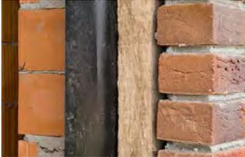
**Bei einem Neubau in massiver Bauweise gibt es drei Möglichkeiten für den Wandaufbau: ein einschaliges Mauerwerk, ein Wärmedämm-Verbundsystem und ein mehrschaliges Mauerwerk.**
