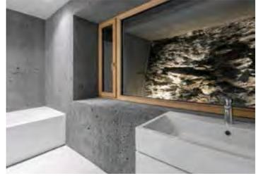
*So genannter Dämmbeton kann für tragende und nichttragende Bauteile im Hoch- und Tiefbau verwendet werden – er eignet sich für den Innen- und Außenbereich, für Mauern, Decken und Fassaden, für Keller und Magazine u.v.m.*
