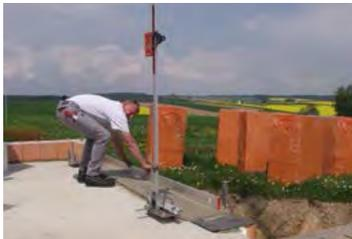
**Einlegen einer Bitumenbahn R 500 nach DIN 18133-1 und Herstellen des Mörtelbettes**
