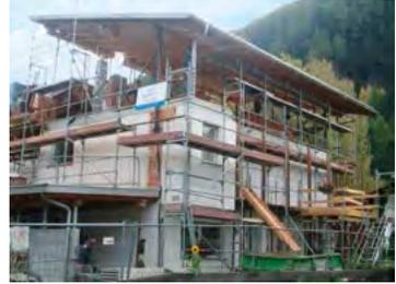
Hand: Der Bauherr profitiert von einer enormen Zeit- und Geldersparnis, außerdem werden die Bauarbeiten witterungsunabhängig durchgeführt, da das bestehende Dach während der gesamten Dauer der Arbeiten schützend über dem Gebäude schwebt.
