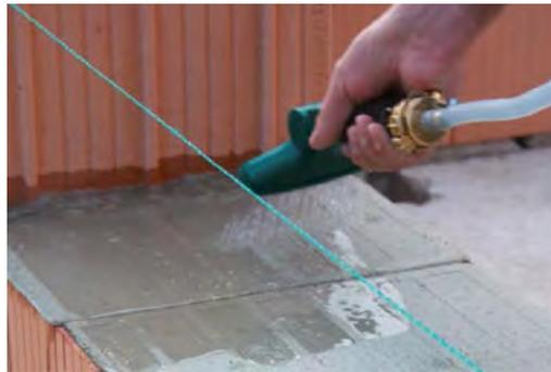
Sie ermöglichen eine vollflächige Deckelung der Lagerfugen und kraftschlüssigen Verbund des Mauerwerks. Das Anmischen von Mörtel und Mörtelauftragsgerät ist nicht erforderlich. Im erhärteten Zustand sind die Festigkeitseigenschaften des Mörtelbands mit bewährten, am Markt verfügbaren Dünnbettmörteln vergleichbar. Mörtelpads sind nicht brennbar (Baustoffklasse A1), weisen Haftscherfestigkeiten von  $> 0,5 \text{ N/mm}^2$  auf, sind wärmedämmend (Wärmeleitfähigkeit  $\lambda = 0,208 \text{ W/}$
