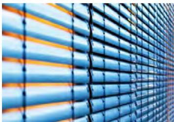
*Durch die auch nachträglich mögliche Montage von Raffstores wird die Wärmeeinstrahlung ins Hausinnere bereits außen deutlich verringert (um ca. 90 Prozent). Somit kann auch der Einsatz von Klimaanlage verringert werden.*
