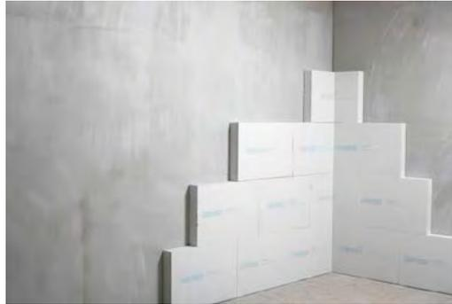
**Durch eine Innendämmung wird die Oberflächentemperatur erhöht; dadurch wirkt die Wärme im Raum trotz einer niedrigeren Raumtemperatur angenehm.**
