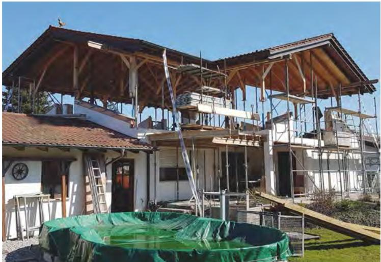
*Auf Knopfdruck wird das Dach horizontal millimetergenau langsam nach oben bewegt, bis die gewünschte Höhe erreicht ist. Hier bei einem Holzhaus.*
