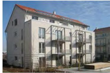
**Wohnanlage mit 50 Wohneinheiten in Frankfurt im Passivhausstandard. Baujahr 2010. Außenwand: einschaliges Ziegelmauerwerk, Wanddicke 49 cm, Wärmeleitfähigkeit  $\lambda = 0,07$  W/mK. Beheizung über Lüftungsanlage mit Wärmerückgewinnung und Einzel-Gasthermen in den Wohnungen. Warmwasser über Solarthermie.**
