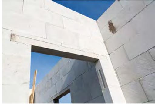
schutz besitzen sie einen Vorteil im Vergleich zu anderen gleichschweren Baustoffen durch ihre innere Dämpfung. Porenbeton benötigt eine Schutzschicht in Form eines Außen- und Innenputzes, wobei Zementputze nicht geeignet sind und durch eigene Leichtputze für Mauerwerke aus Porenbeton ersetzt werden sollten.
