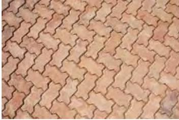
se. Die ungebundene Bauweise mit bindemittelfreien Materialien ist dabei der Regelfall für Pflasterbeläge. Bei gebundener Bauweise werden für Bettung, Tragschicht und meist auch für das Fugenmaterial bindemittelhaltige Baustoffe verwendet.
