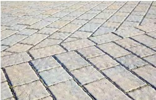
*Betonpflastersteine sind langlebig, ästhetisch und sehr belastbar, je nach Stärke mit schweren Fahrzeugen befahrbar. Durch das Verfugen mit Feinsand wird der Graswuchs unterdrückt, Öl- und Schmutzflecken verschwinden mit der Zeit von alleine.*
