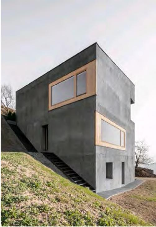
mineralischer Leichtzuschlag in verschiedenen Korngrößen, Zement, Wasser und spezielle Betonzusatzmittel beigemischt. Die Farbauswahl
