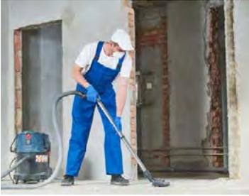
**Bei der Baugrobreinigung werden in den einzelnen Bauphasen Bauschutt, Verpackungsreste und grobe Verschmutzungen entfernt. Dadurch soll den Handwerkern die Arbeit erleichtert werden. Zudem ist es leichter, Baumängel zu entdecken.**
