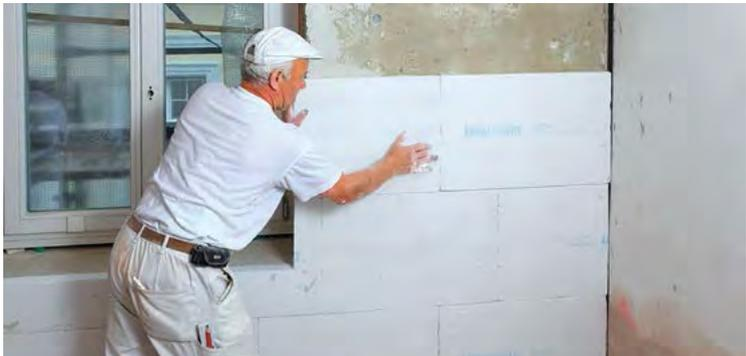
kleinste Materialfehler, unsachgemäße Montage oder arbeitendes Mauerwerk können leicht zu Haarrissen in der Dampfsperre und zur Ablagerung von Feuchtigkeit führen. Schimmelbildung über kurz oder lang ist bei dieser „Lösung“ vorprogrammiert. Es ist also wesentlich sinnvoller, darauf zu achten, dass das anfallende Tauwasser gespei-
