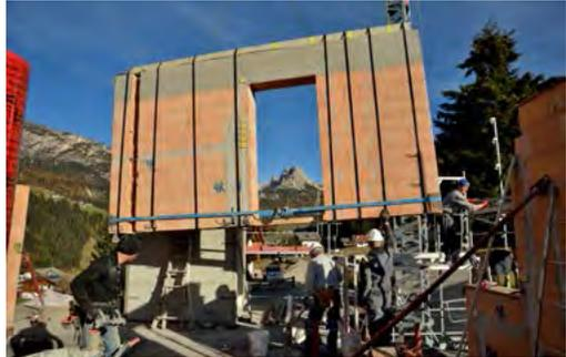
*Bei der Fertigbauweise, egal, ob mit Ziegelteilen oder mit Holzelementen, werden Wände und Decken komplett angeliefert – und in kurzer Zeit direkt vor Ort montiert.*
