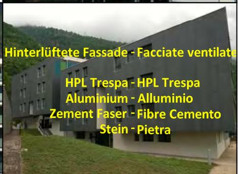
Hinterlüftete Fassade - Facciate ventilate
