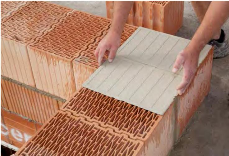
Das Dryfix-Ziegelmauerwerk wird auf der üblichen, im Normalmörtel nivellierten ersten Ziegellage erstellt. Der Planziegelkleber wird mit einer speziellen Klebepistole auf die staubfreien Planziegel aufgetragen. Bei Temperaturen unter +5 °C müssen die Planziegel trocken sein, bei darüberliegenden Temperaturen sollte die Klebefläche angefeuchtet werden. Planer und Anwender sind hinsichtlich der Besonderheiten des Anwendungssystems Dryfix Planziegelkleber durch den Zulassungsinhaber zu schulen.
