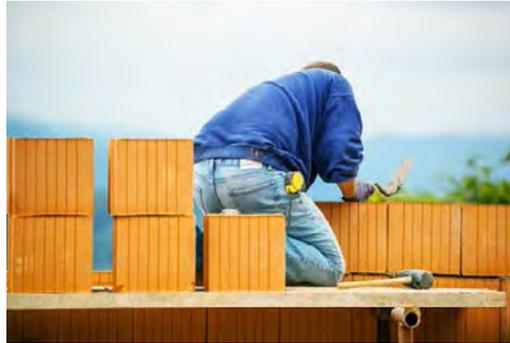
allen Anforderungen entsprechen. Bei einem einschaligen Ziegelmauerwerk muss der Ziegel die Aufgaben der Wärmedämmung, des Schallschutzes und der Statik übernehmen. Um eine entsprechenden Wärmedämmung zu erhalten, ist es notwendig, einen hochdämmenden
