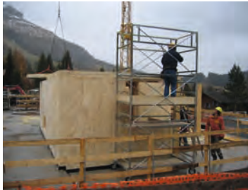
Montage Fertigteile mit Rollgerüst
