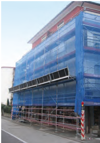
Ordnungsgemäß errichtetes Fassadengerüst
