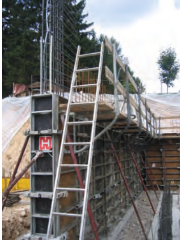
Betonarbeiten mit Konsole- gerüst auf Schalung
