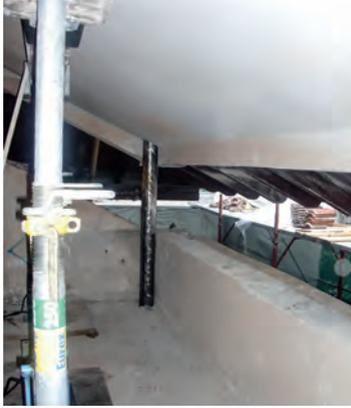
die Dauer der Bauarbeiten schützend über dem Gebäude positioniert. Der Aufbau der Seitenwände bis zur neuen Unterdachhöhe kann unverzüglich und witterungsunabhängig erfolgen. Neben der schnelleren und einfacheren Abwicklung bietet die hydraulische Dachanhebung auch
