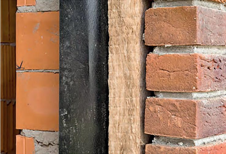
*Bei einem Neubau in massiver Bauweise gibt es grundsätzlich drei Möglichkeiten für den Wandaufbau: ein einschaliges Mauerwerk, ein Wärmedämm-Verbundsystem und ein mehrschaliges Mauerwerk.*
