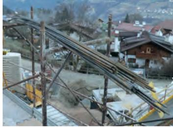
*Unsachgemäße Lagerung von Baumaterial auf Fassadengerüst*
