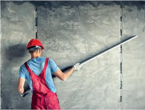
bracht wird. Je nach Einsatzart erfüllt der Putz verschiedene Zwecke, z. B. die Herstellung eines glatten Untergrundes (zum Fliesen, Streichen oder Tapezieren), die Regulierung der Raumfeuchte (bei Innenputzen), die Wärmedämmung und Wasserabweisung (bei Außenputzen) und natürlich die Herstellung eines ästhetischen Erscheinungsbildes. Der Putz ist somit
