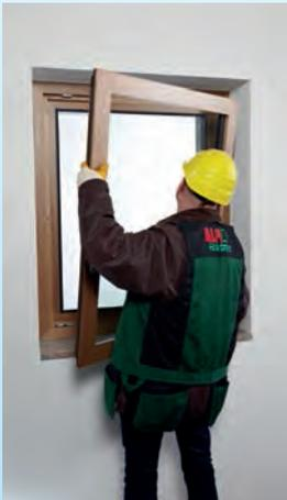
**Fenstermontage:** Häufig rufen Glassplitter Verletzungen hervor, die durch einfache Maßnahmen hätten vermieden werden können. Unfallschutz beim Fensterbau bedeutet: Abhängig von der Einsatzart müssen Fenster genormte Sicherheitsgläser besitzen.
