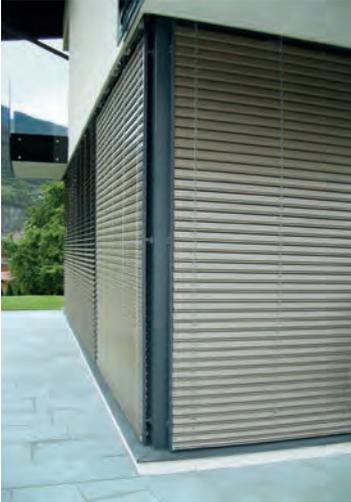
*Raffstores sind witterungsfeste, flexibel regulierbare Außenjalousien mit dem Vorteil, dass sie den Lichteinfall optimal regulieren können, ohne die Sicht nach außen zu versperren. Sie schützen nicht nur vor Sonne oder Einblicken, sondern sorgen auch für ein behagliches Raumklima durch stufenlose Lichtregulierung. Zusätzlich bieten Raffstores eine optimale Abdunkelung und sind ein zuverlässiger Schutz gegen Wind und Wetter.*
