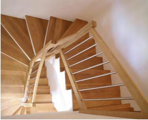
Tragholmen aufgesetzt. Dazu können die Wangenoberkanten ausgeschnitten und die Stufen darauf und oder die Stufen mittels einem Stufenkeil auf den Tragholm gesetzt werden. Die Dicke der Stufen liegt bei ca. 40 bis 70 Millimetern.
