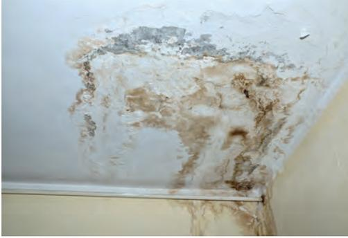
**Folgende Untersuchungen des Mauerwerks sind vorab immer erforderlich: die Ermittlung der Feuchtigkeitsursache, die Bestimmung der wasserlöslichen und bauschädigenden Salze, die Ermittlung der Art und des Zustandes des zu verputzenden Mauerwerks.**
