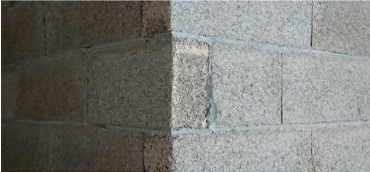
*Raumschall wird aufgrund der groben Oberfläche bei Hanfziegeln drastisch geschluckt.*
