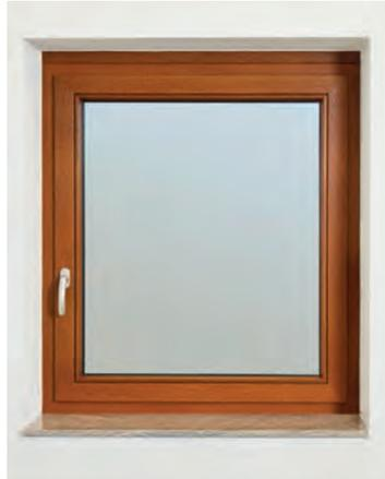
mung erreicht. Die Auswahl der Holzart ist von entscheidender Bedeutung. Dreischichtverleimtes Hartholz ist enorm widerstandsfähig und bietet die Sicherheit, wohl eines der besten Hölzer für den Fensterbau zu erhalten.
