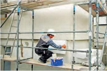
bundsystems nicht in Frage, da die Dämmung ausreichend ist oder der Bauabstand eine solche nicht zulässt, ist ein Dickschicht-Saniersystem die effektivste Sanier- bzw. Renovierlösung.
