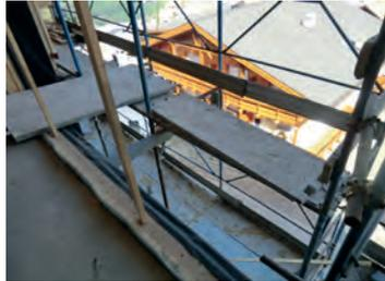
*Ausgebaute Trittflächen am Fassadengerüst*
