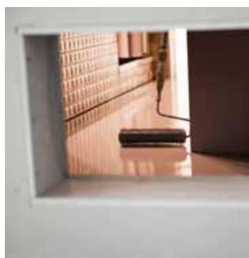
**Das Auftragen der Epoxidbeschichtung erfolgt gleichmäßig mit einer Rolle, einem Pinsel oder einer Spachtel. Epoxidharzböden können recht schnell verlegt werden – auf ein ausreichendes Trocknen und Aushärten ist aber zu achten.**
